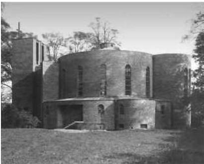
*Ansicht wie vor; ein erster Entwurf zielt auf die baukörperliche Ergänzung des Äußeren der Kirche durch Schließen der ausgesparten Zylinderzonen mithilfe einer "zweiten Außenhaut" aus Glas. Die fünf Bogenfenster werden in die äußere Schale verlegt, der Innenraum des Gebäudes erhält auf diesem Wege eine Galerie. Durch diese Maßnahme wird das Platzangebot erhöht, zugleich der Charakter des Zentralbaus betont.*
