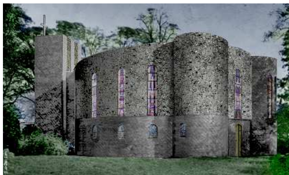
Hamburg, St. Mariae Himmelfahrt, Ansicht des Projekts von Süd. Ergänzung des vorhandenen ringförmigen Umgangs im Erdgeschoss um eine Emporenzone im Obergeschoss. Außen sichtbar durch Materialwechsel Ziegelmauerwerk zu Naturstein hier: Nadelfluh, gelegentlich auch Naturbeton genannt.
